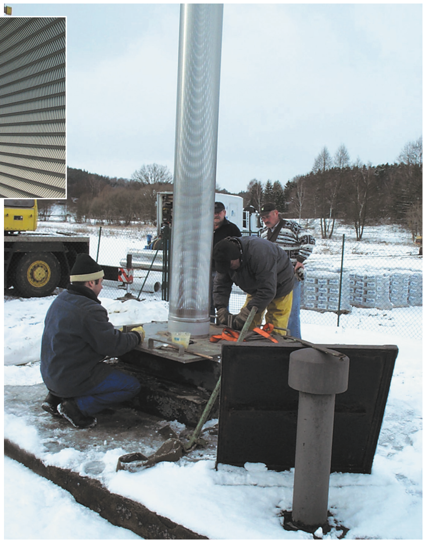
Das Versenken des Filterrohres erforderte einiges an „Manpower“ Foto: Manfred Piewak
